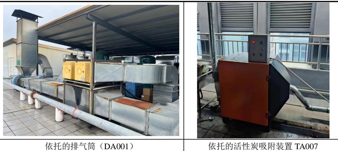
图 4-1 废气污染防治措施照片
